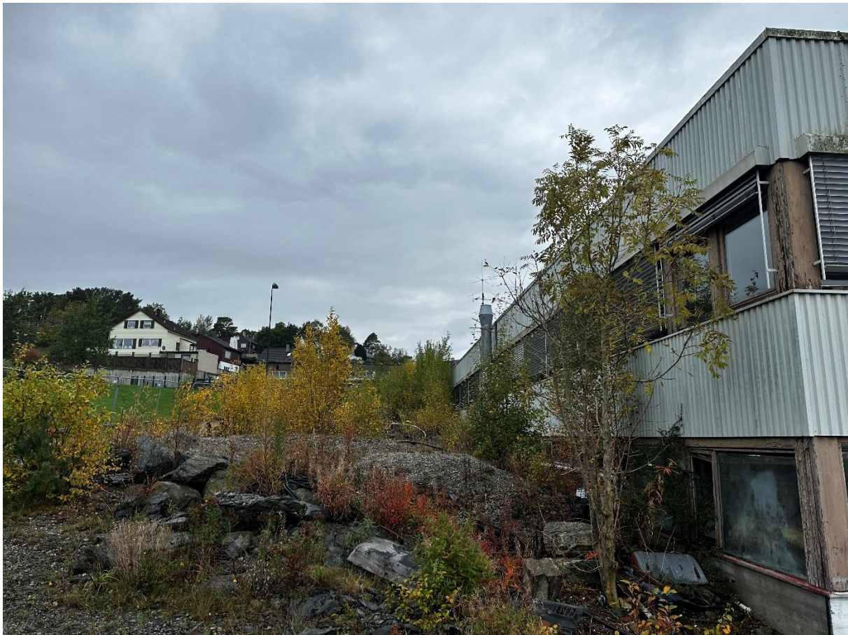
Figur 4.3: Oppslag av ask (EN) inntil veggen av bygningen.
