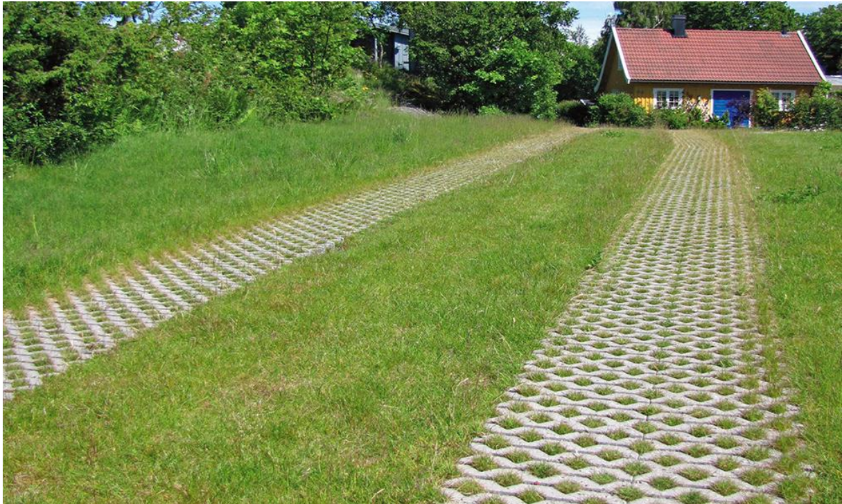
Figur 15: Bildet illustrerer bruken av gressarmering på feltene hvor bildekkene treffer bakken. Bildet er hentet fra www.hmhcement.no .
