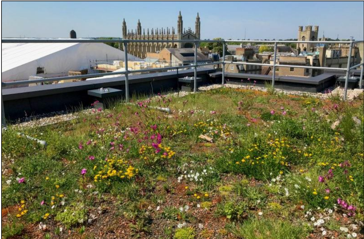
Figur 12: Taket på David Attenborough Building i Cambridge, illustrerer et artsrikt grønt tak. Bildet er hentet fra https://livingroofs.org/ .
