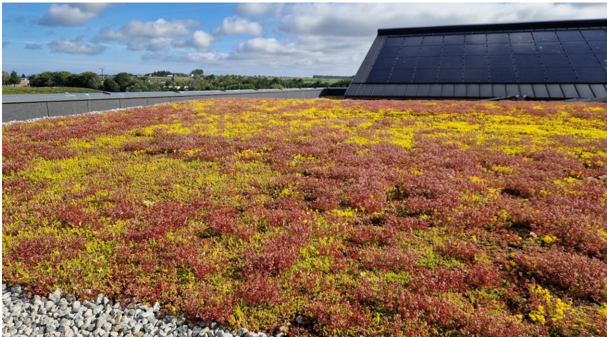
Figur 13: Bildet illustrerer hvordan et tak beplantet med sedum kan se ut. På dette aktuelle taket hekket både rødlistede måker og tjeld. Foto: Rebekka Sundøy Haldorsen
